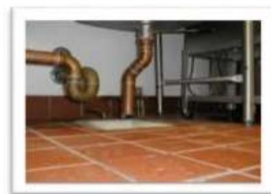
Salidas de aire instalados en líneas de aguas residuales de fregaderos de preparación de alimentos, lavadores de cucharas, depósitos de hielo y máquinas de lavado de vajilla.
